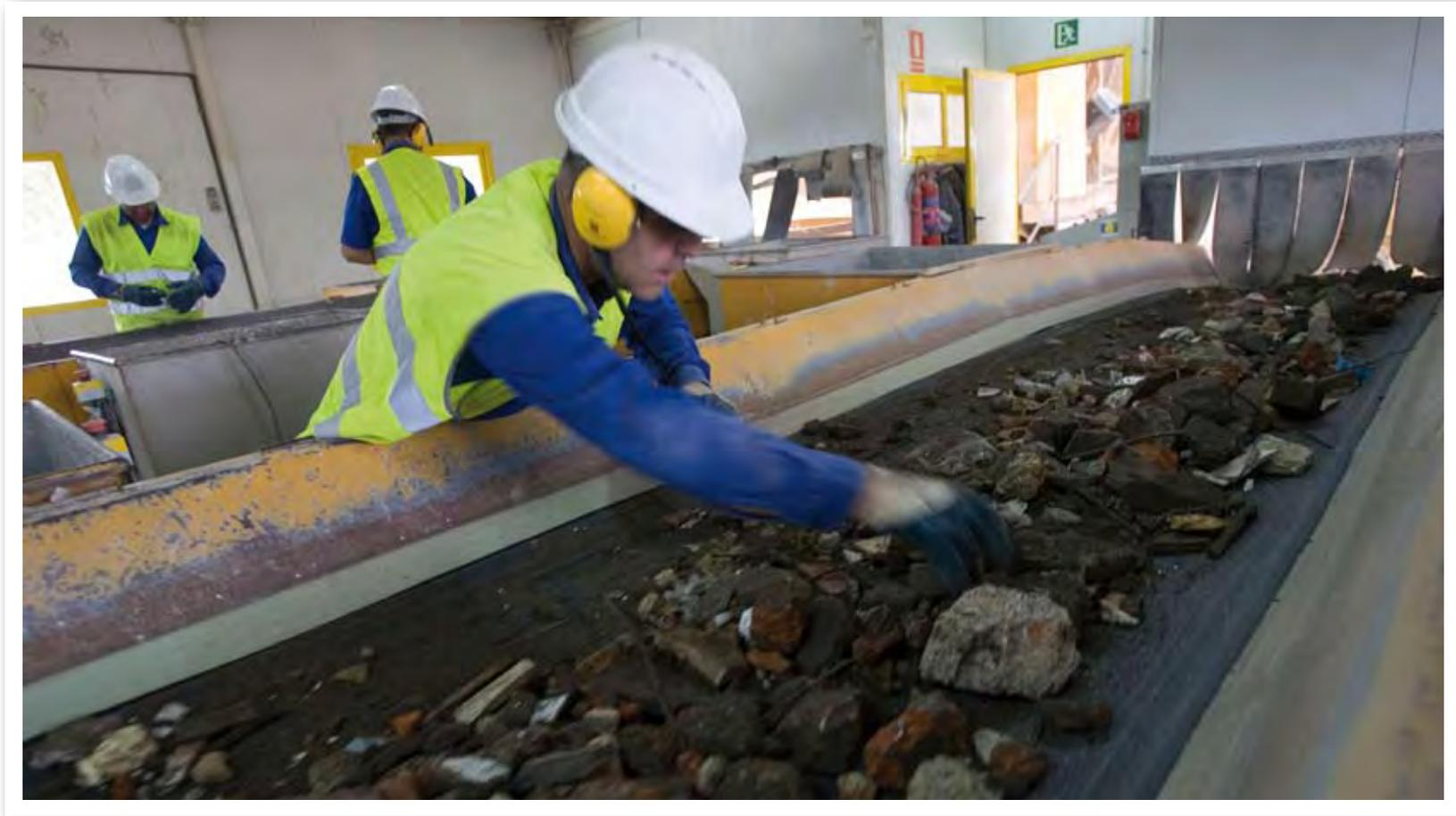
En torno a 300.000 toneladas de residuos de construcción y demolición llegan anualmente a COGERSA desde que, a finales del año 2.004, se pusieron en marcha la planta de reciclaje de escombros y el vertedero de inertes del valle de La Oscura.
